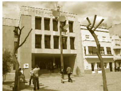
Campus de Orihuela Sede de las Salesas Plaza de Las Salesas, s/n. 03300 ORIHUELA
